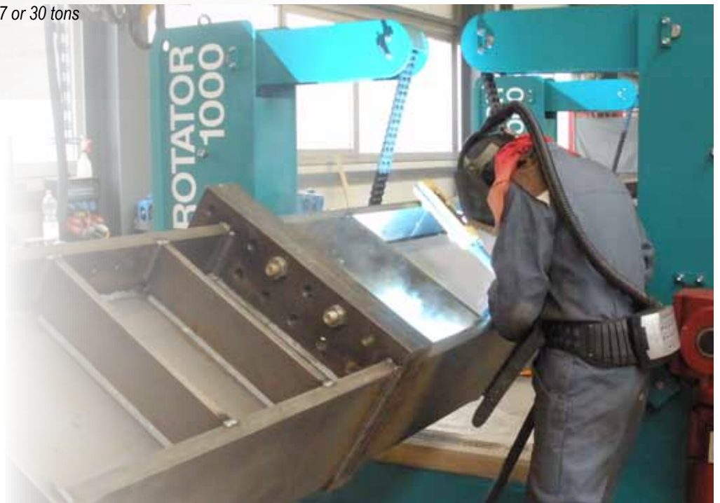
312 Schweißen und Verputzen in Wannenlage erhöht die Produktivität Welding and dressing in sag curve increases productivity
