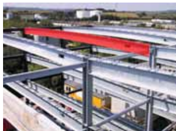
120 Stahlbauer nutzen die Vorteile Steel fabricators use the advantages
